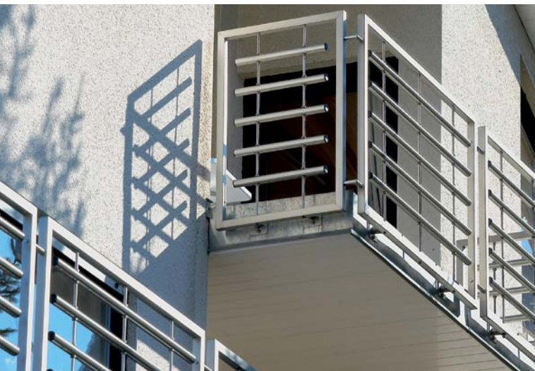
Bei Befestigung einer Geländerkonstruktion müssen diverse Lasten berücksichtigt werden. Über die fachgerechte Befestigung berichten Dipl.-Ing. (FH) Joachim Mauz und Dipl.-Ing. Luis Washington. Seite 70
