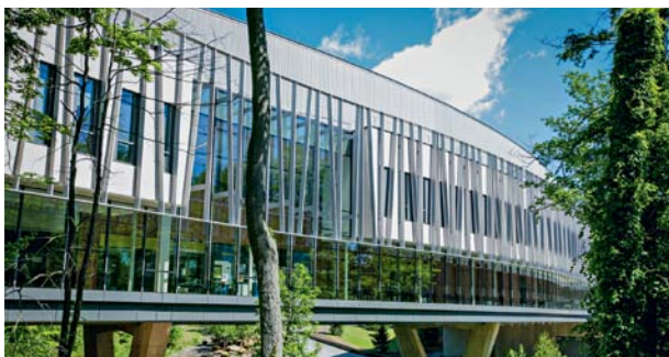
Vogelschutzglas Isolar Ornilux am Vassar College/USA.
