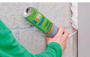
Fugenfüller JF100 ist 100 % isocyanatfrei und innenraumtauglich.
