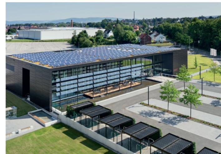
An der Fassade des neuen Schulungsgebäudes von Stiebel Eltron in Holzminden wurde ein optimierter Sonnenschutz eingesetzt: Sowohl die PV-Anlage als auch die Aluminiumlamellen werden nach dem Sonnenstand geführt. [Seite 62](#)
