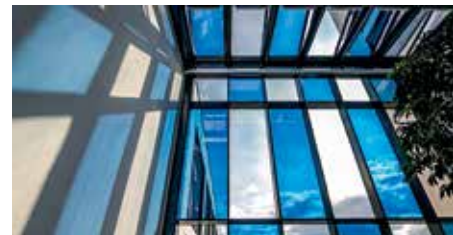
Das elektrochrome EControl-Glas lässt sich dimmen und reduziert die sommerliche Hitze.
