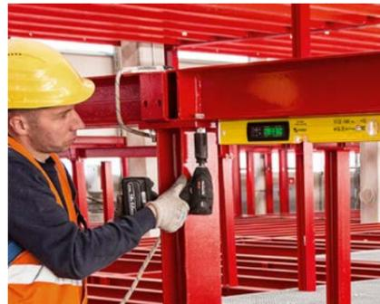
Dank Seitenerd-Magnetsystem haftet die Wasserwaage an metallischen Bauelementen.
