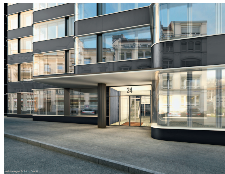
Die erste Wicona Fassade nach dem CCF-Prinzip (AXA Winterthur-Versicherung, Zürich).
