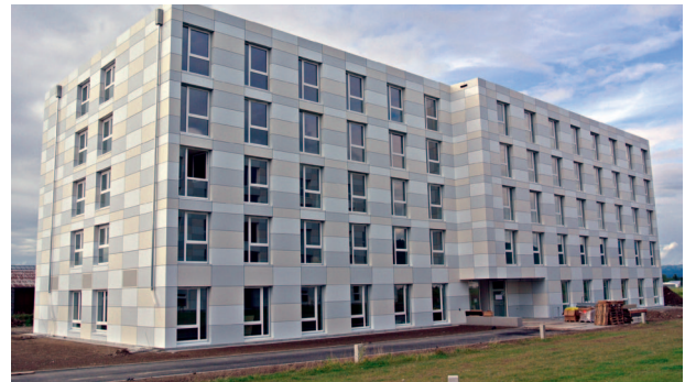
Für die Alucobond-Fassade beim Campus III in Freiburg kam Tekofix mit Alwi zum Einsatz.
