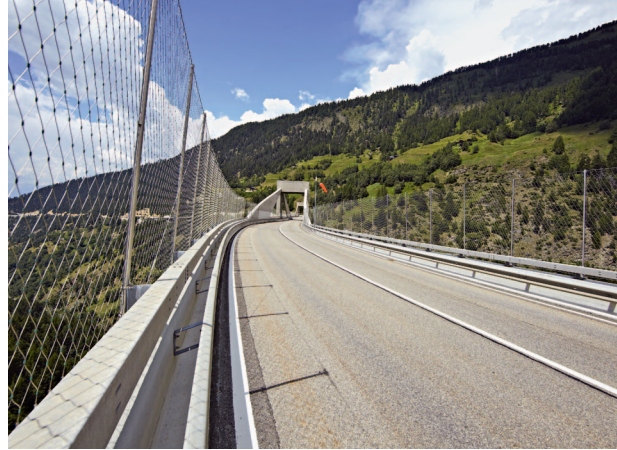
Ganterbrücke: Suizid-Barriere mit Webnet-Konstruktion.
