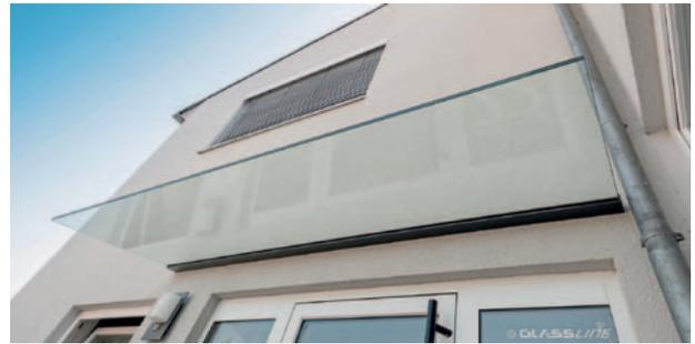
Das Konzept ist freitragend bei einer maximalen Ausladung der Glasscheibe bis zu 1.900 mm.
