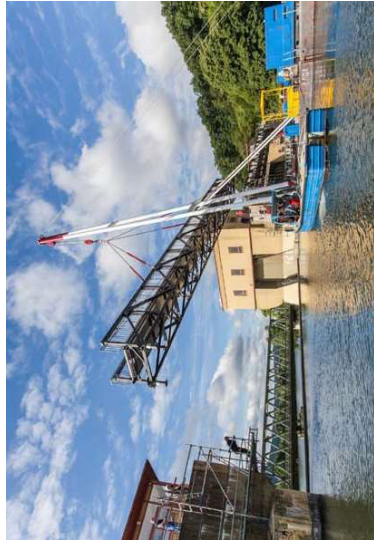
Peter Maier Leichtbau in Singen baut Brücken aus Aluminium, dank seines patentierten Modulsystems bietet der Brückenbauer wirtschaftlich interessante Konstruktionen an. Seite 14
