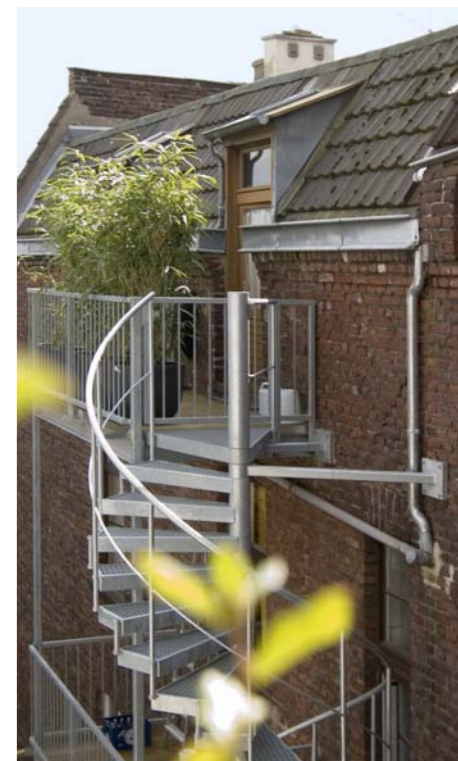
Spindeltreppen im System mit baulichem Zuschnitt für den Außenbereich.
