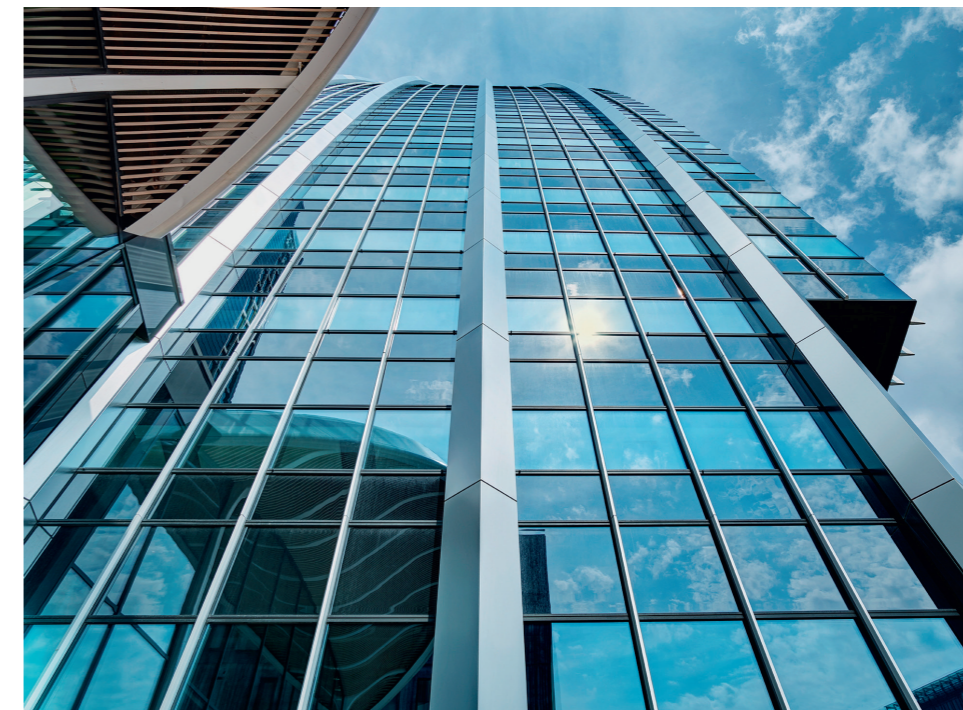
The Triple Insulating Glass is a combination of the Saint Gobain Planiclear pane type, Cool-Lite SKN and Planitherm Ultra N. Das Dreifach-Isolierglas ist eine Kombination der Saint Gobain Scheibentypen Planiclear, Cool-Lite SKN und Planitherm Ultra N.
