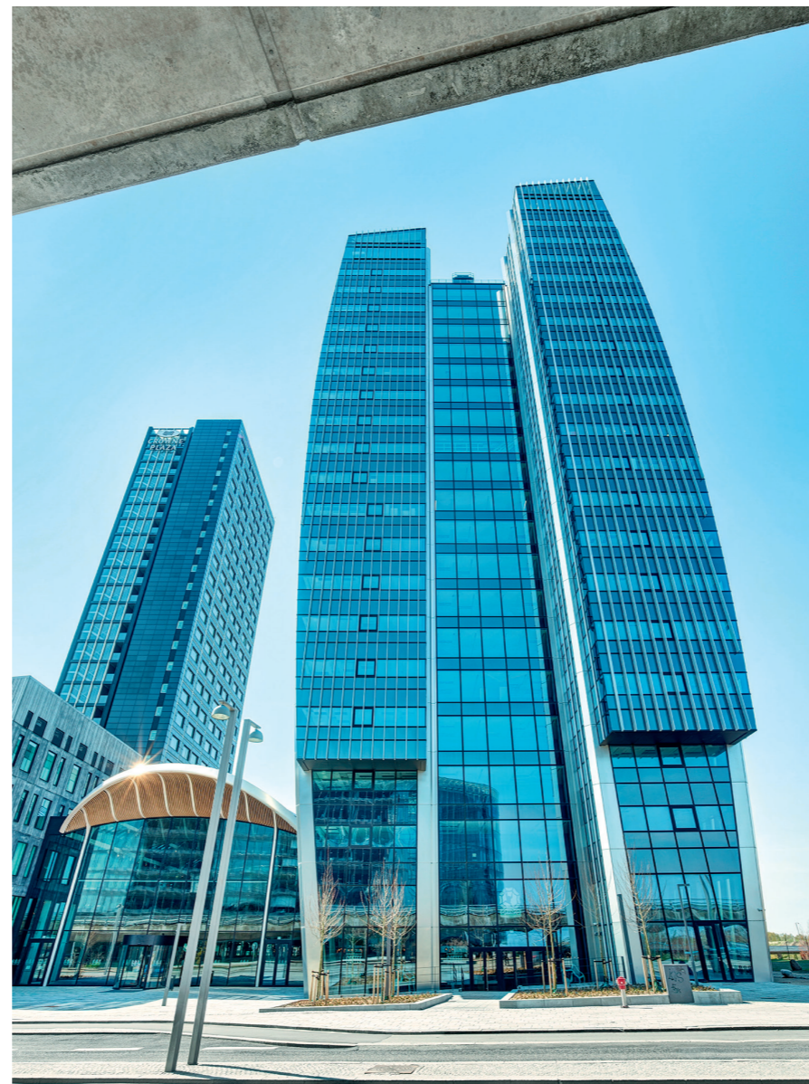
The constructors achieved the curve of the post and mullion façade over a height of nearly 90 m through a polygonal arrangement in the area of the vertical unit joint. Die Krümmung der Pfosten-Riegel-Fassade über eine Höhe von fast 90 Metern wurde durch eine polygonale Anordnung im Bereich des vertikalen Elementstoßes erreicht.
