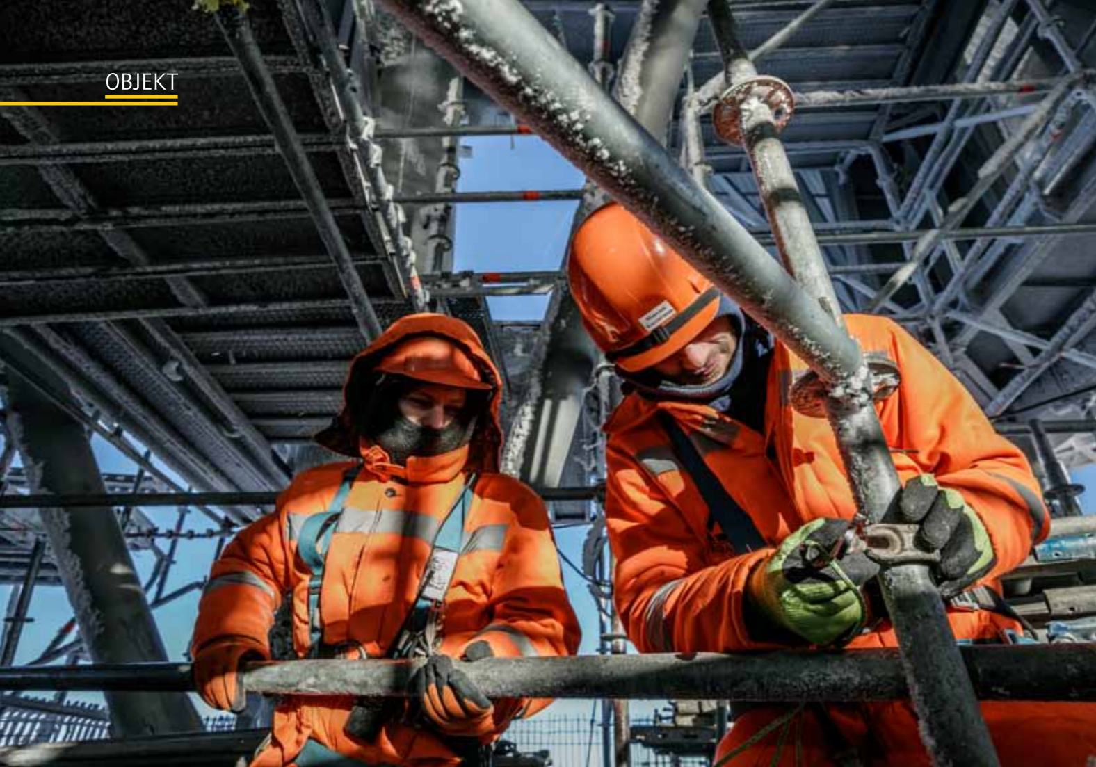
In wintertime the fitters worked a couple of days at 25 degrees below zero at the construction site. To heat this areas they were delimited with curtains. Die Monteure haben im Winter teils bei minus 25 Grad auf der Baustelle gearbeitet. Montagestandorte wurden räumlich mit Behängen abgegrenzt und beheizt.
