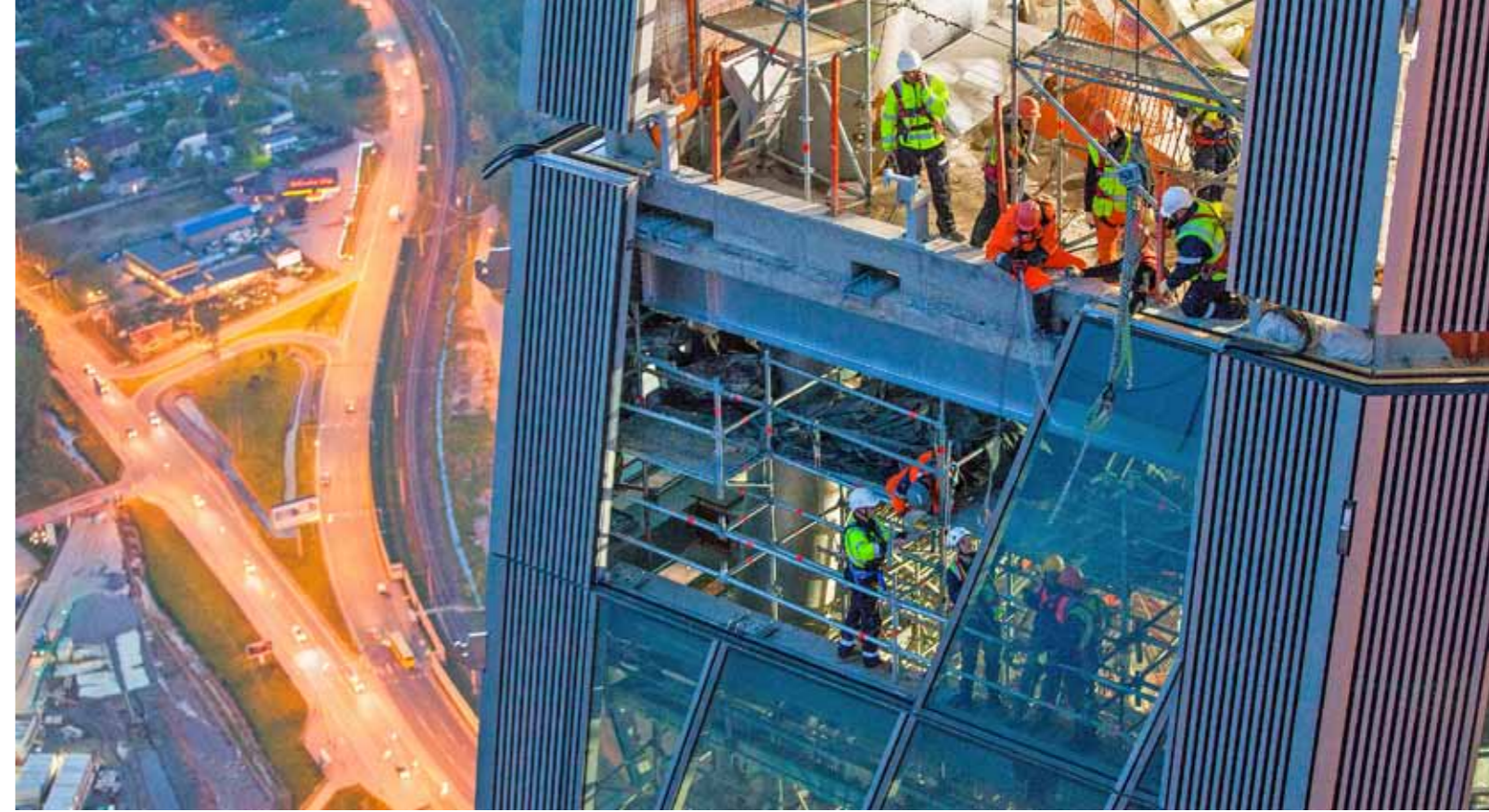
The fitters installed more than 16.500 unique alu-glass-elements. Most of them have a format of rhomboid and one of them weighs over 700 kilogramm. Die Monteure bauten über 16.500 unterschiedliche Alu-Glas-Elemente ein. Die meisten Fassadenelemente am Turm haben die Form eines Parallelogramms.
