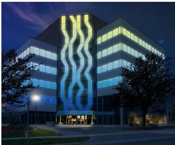
Beim Aktivglas „Glassiled Uni“ ermöglichen RGB-LEDs in der Rahmenkonstruktion die gleichmäßige Illumination von Teilen der Fassade. Am Tag unterscheiden sich die Scheiben optisch nicht vom normalen Glas.
