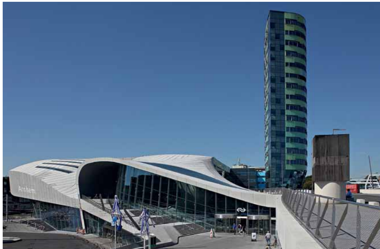
The hall's substructure consists of two 10 mm thick steel shells that are connected to each other by a steel rib design. Die Unterkonstruktion der Halle besteht aus zwei 10 mm starken Stahlschalen, die über eine Rippenkonstruktion verbunden sind.
