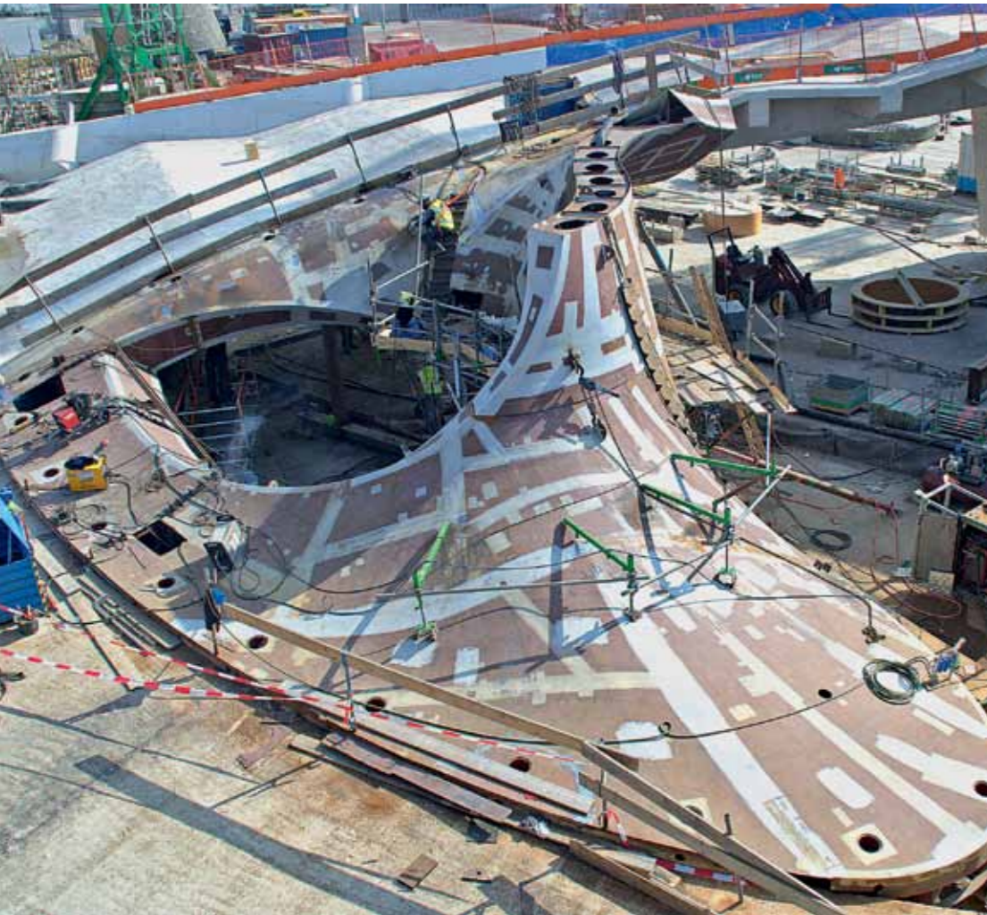
In the area of the „twist“, the only hall support that was used were metal sheets up to 60 mm thick. Im Bereich des »Twists«, der einzigen Hallenstütze, kamen bis zu 60 mm dicke Bleche zur Anwendung.
