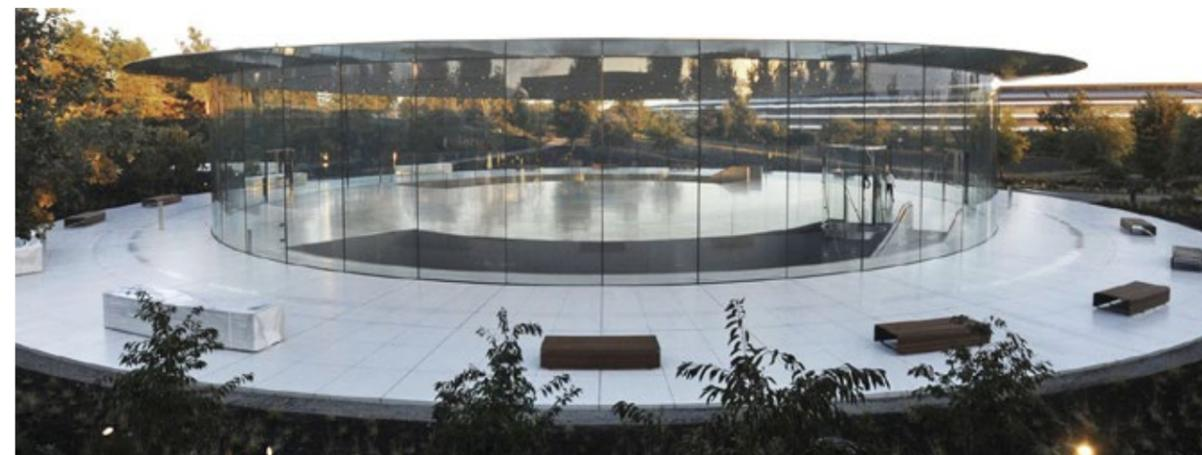
The carbon roof, which measures 47 m in diameter and weighs 80 t, sits without a frame on the 7.3 m high curved glass panes. Das im Durchmesser 47 m messende und 80 t schwere Carbon-Dach sitzt ohne einen Rahmen auf den 7,3 m hohen gebogenen Glasscheiben.
