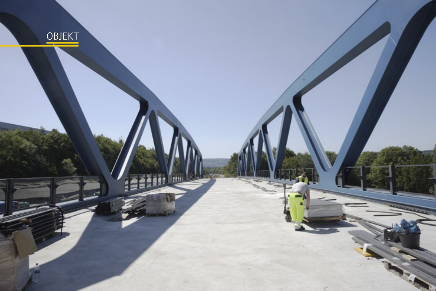
Both bridges were prefabricated except for the topmost asphalt surface and the side roadway banquettes. Beide Brücken wurden bis auf die oberste Asphaltdecke und die seitlichen Fahrbahnbankette vorgefertigt.
