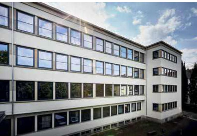
Metakon-Metallbau hat für die Schollerschule in Saarbrücken 300 Fenster saniert. Vorgaben des Denkmalschutzes wurden mit einem Profilsystem von Hueck und Beschlägen von Roto Alu Visions umgesetzt. [Seite 62](#)
