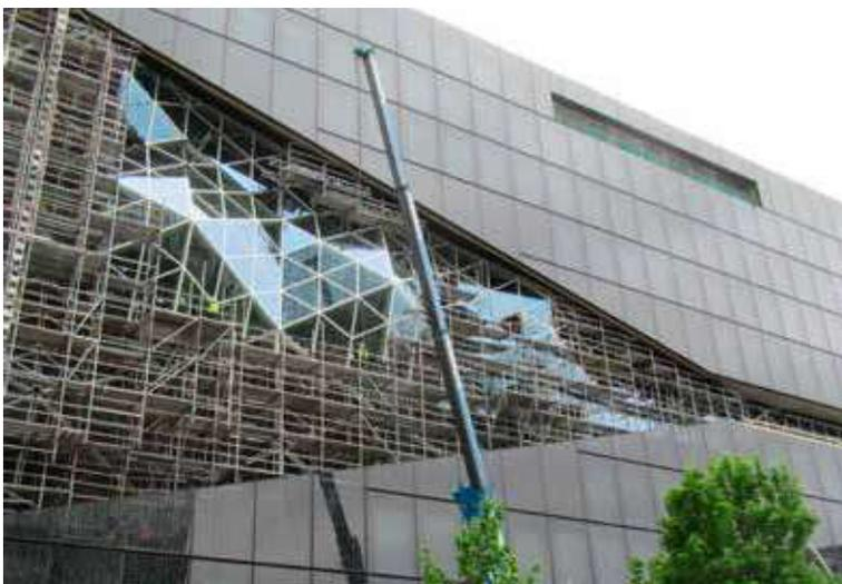
Glasdreiecke im Relief charakterisieren das Atrium, mit dem GIG Fassaden für den Axel-Springer-Neubau in Berlin beauftragt ist. Das Bauwerk im Bauwerk ist statisch autonom und wurde mit speziell entwickelten Brückenlagern am Rohbau befestigt. **Seite 44**
