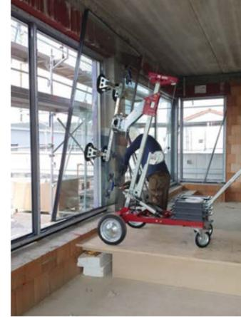
Das Glasmontagegerät UPT 250 von Uplifter ist leicht zu transportieren und kann schnell auf- und abgebaut werden.
