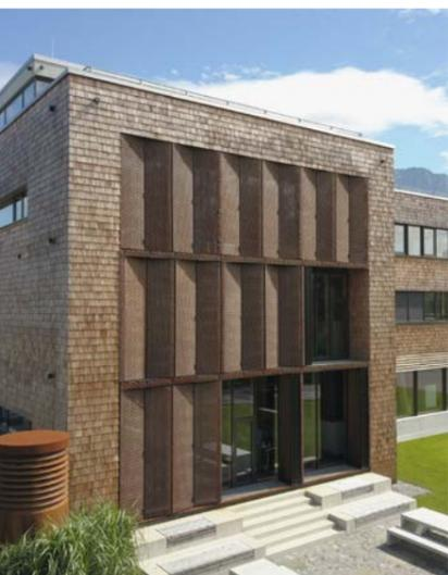
Die Firma Hype, ein Tochterunternehmen der Colt-Gruppe hat das neue Bora Büro-Gebäude im österreichischen Niederndorf bei Kufstein mit Schiebefaltladen aus Cortenstahl ausgestattet. So ist ein nicht alltäglicher Bürobau entstanden, der durch überdimensionale Glaselemente und ein Fassadenkleid aus Lärchenschindeln besticht, während die Tragstruktur mit lebhaften Stahlbetonflächen sichtbar und markant bleibt. Abgerundet wird das hochwertige Gesamtbild durch einen von innen nach außen
