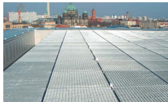
Gitterroste werden gerne für Böden, Fassaden und Treppen genutzt.
