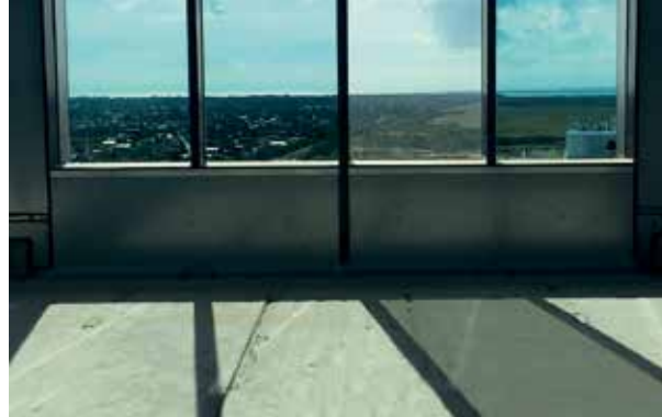
Infrashade – dritte Scheibe von links – bietet Verschattung, Transparenz und reduziert den Wärmeeintrag.
