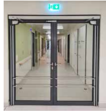
Mit dem NR-32 lassen sich Automatiktüren normkonform absichern.
