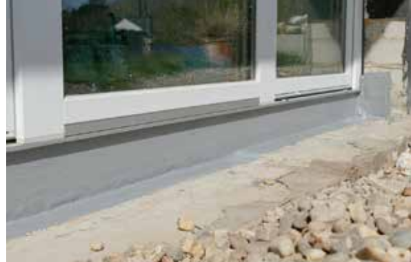
Fertige, bodentiefe Fensterabdichtung mit dem Soudatight WP.
