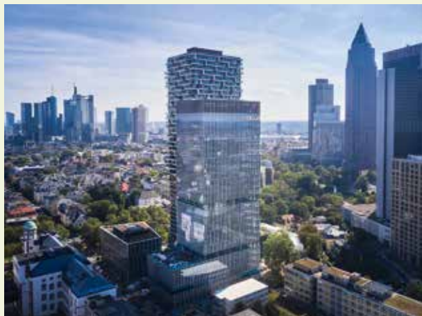
Die Fassade des 106 Meter hohen Senckenberg-Turms in Frankfurt wurde zu 95 % mit recyceltem Aluminium realisiert.
