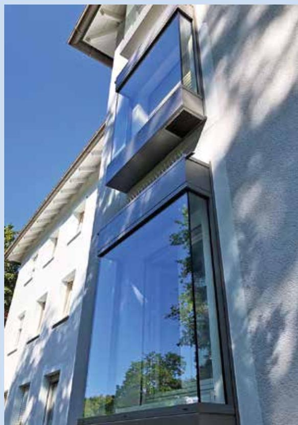
Schallschutzkästen vor dem Fenster reduzieren den Lärmpegel in den Räumen signifikant.
