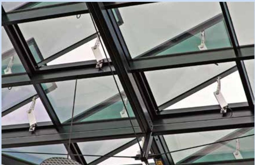
Mit dem Klapparm<sup>2</sup> lassen sich mechatronische Fenster an Fassade und Dach öffnen.
