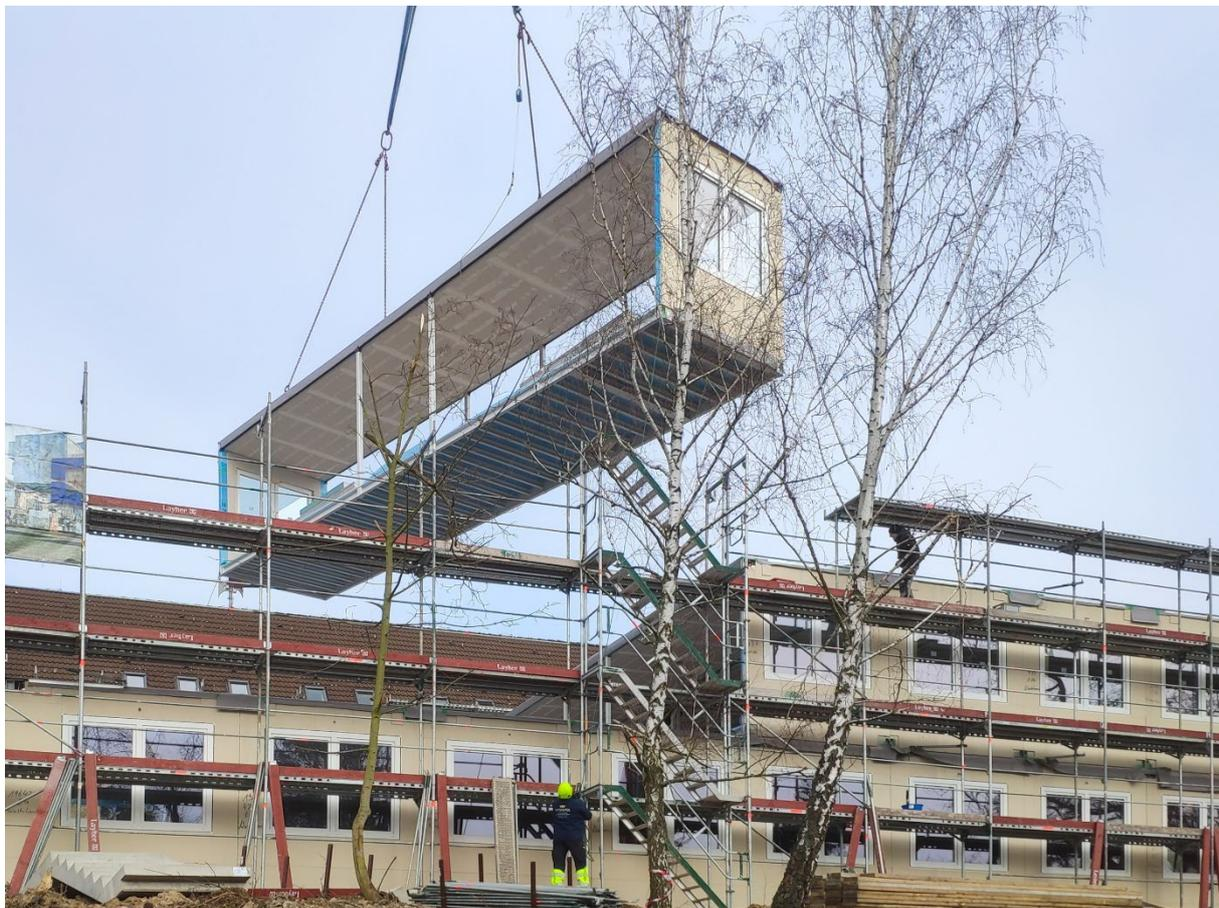
Bei der modularen Bauweise werden i.d.R. im Werk sogenannte Module hergestellt, die auf der Baustelle zu baulichen Anlagen oder Teilen baulicher Anlagen zusammenzufügen sind. Die Ausgestaltung der Module kann sehr vielfältig sein und bis hin zu fertig eingerichteten baulichen Anlagen reichen.
