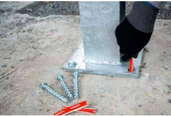
Die Verbundankerschraube HUS4-Max ist eine Kombi aus chemischem und mechanischem Dübel.
