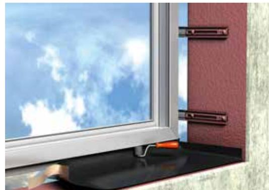
Mit der Fenster-Anschlussabdichtung kann der Schallschutz optimiert werden.
