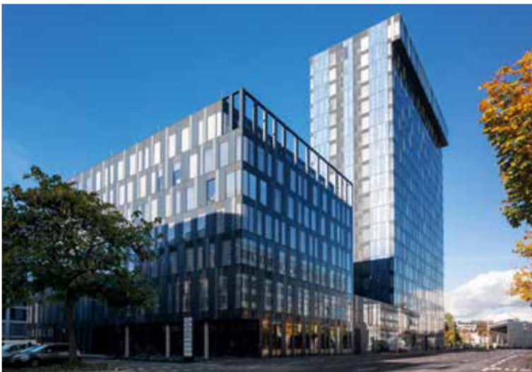
Foto: GIG Fassaden
