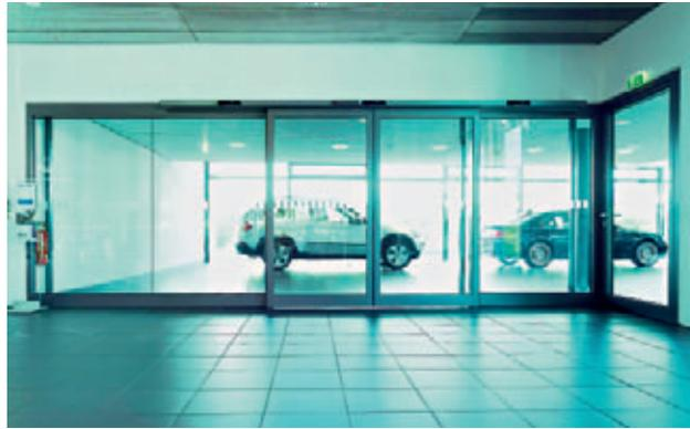
T 30 Schiebetüre in Aluminiumsystemwand integrierbar
